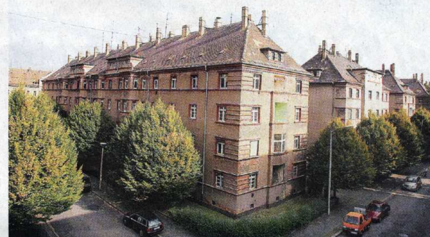
Sanierungsfall: Die Wohnanlage in der Gedickestraße, gebaut 1928 bis 1930, ist leer und mehr und mehr dem Verfall preisgegeben.
