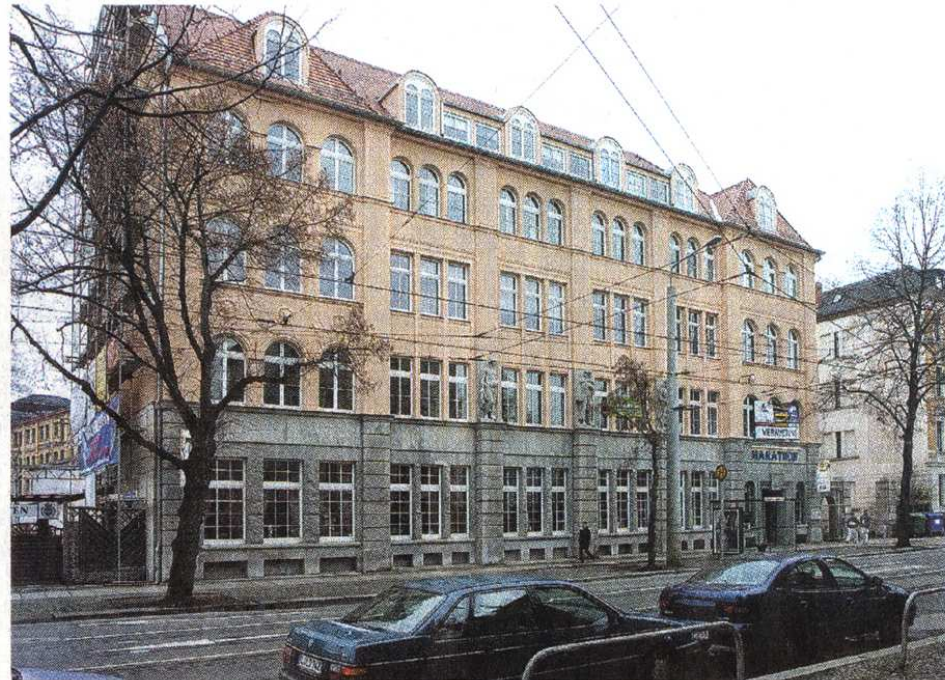
Zu den Gebäuden der früheren Zahnradfabrik gehört auch dieses Haus an der Arthur-Hoffmann-Straße. In dem bereits sanierten Haus sind Wohnungen und Büros entstanden. Bilder: CG
