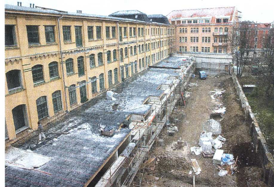
Im rückwärtigen Grundstücksteil entstehen großzügige Maisonette-Wohnungen mit eigenem kleinen Garten. Das Grundstück wurde dafür tiefer gelegt.
