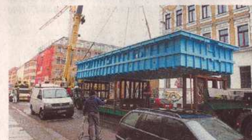
In der Arthur-Hoffmann-Straße hebt ein 100 Tonnen schwerer Kran die Wanne vom Schwerlasttransporter.
