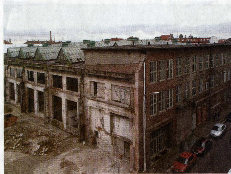
Für den künftigen Unternehmenssitz von Spreadshirt wird derzeit gerade eine alte Fabrikhalle nebst Produktionsgebäude umgebaut. Bilder: CG
