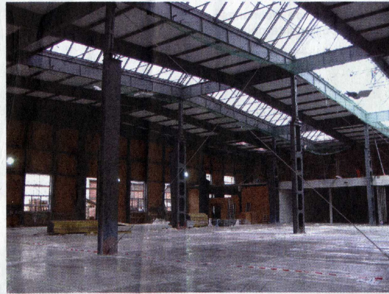
Die alte Fabrikhalle während des Umbaus: Für Spreadshirt soll eine Galerieebene in die lichtdurchflutete Halle eingezogen werden.
