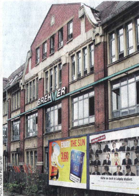
Gerade begonnen: In der Karl-Heine-Straße 109 zieht bald eine Softwarefirma ein.
