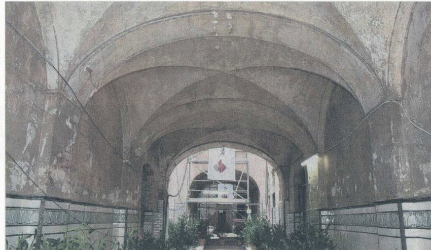
Im Frühjahr 2012 strahlt den Besuchern in der Passage Kleines Joachimsthal ein sanierter Eingangsbereich entgegen. Foto: CG Gruppe
